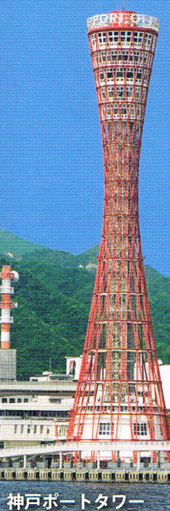
神戸ポートタワー
